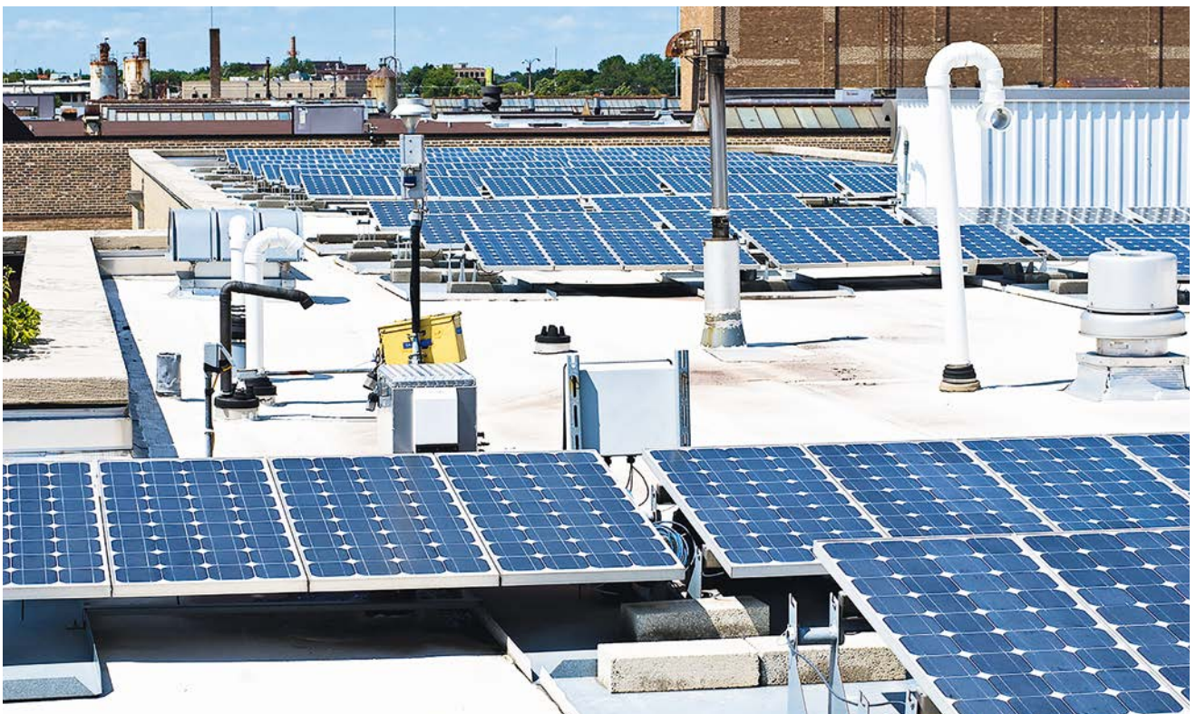
Солнечные панели на крыше Чикагского центра зеленых технологий
