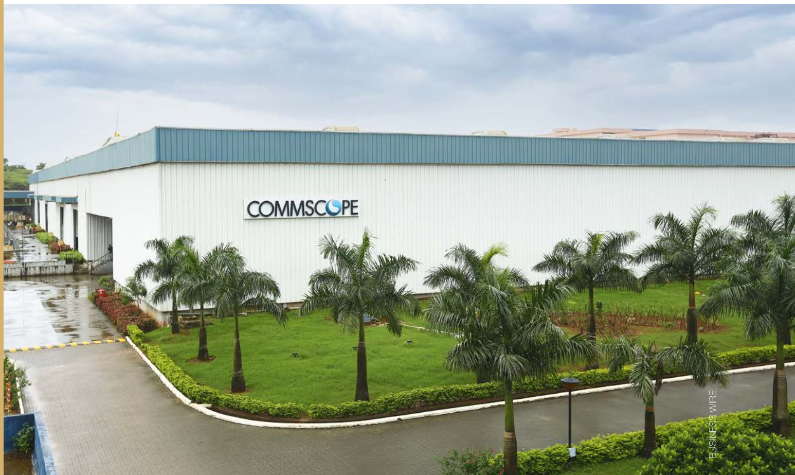
Завод Commscope по производству сетевых кабелей. Гоа, Индия
