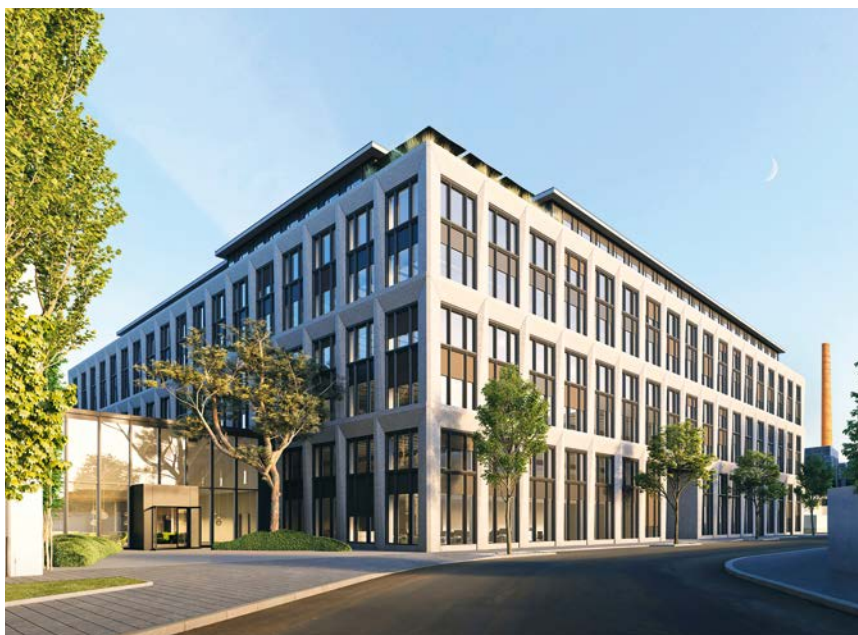
Офисное здание Karl, место будущей лаборатории Apple. Визуализация
